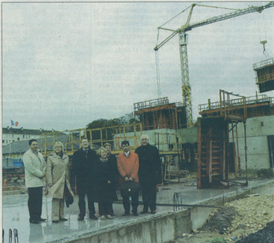
A cet endroit, le futur site des finances publiques à Falaise est en construction.
